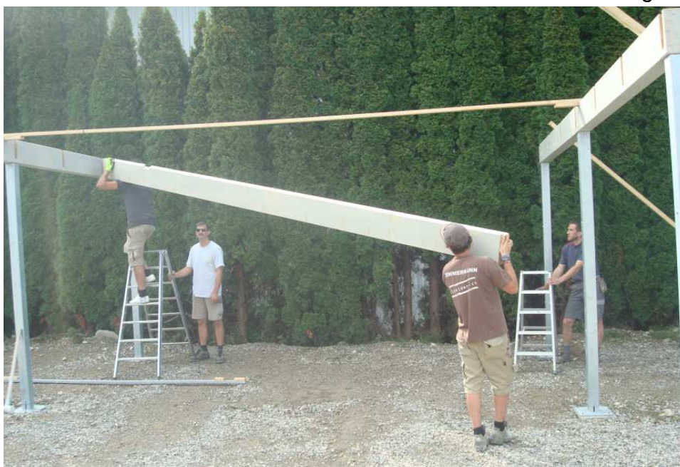
Bei der Balkenmontage unbedingt Leitern gegen ein mögliches Umkippen sichern
