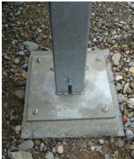
Fertiges Fundament mit aufgeschraubtem Pfosten
