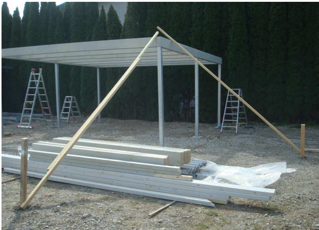
Verankerter Pfosten genau in den Senkel stellen und verstreben
