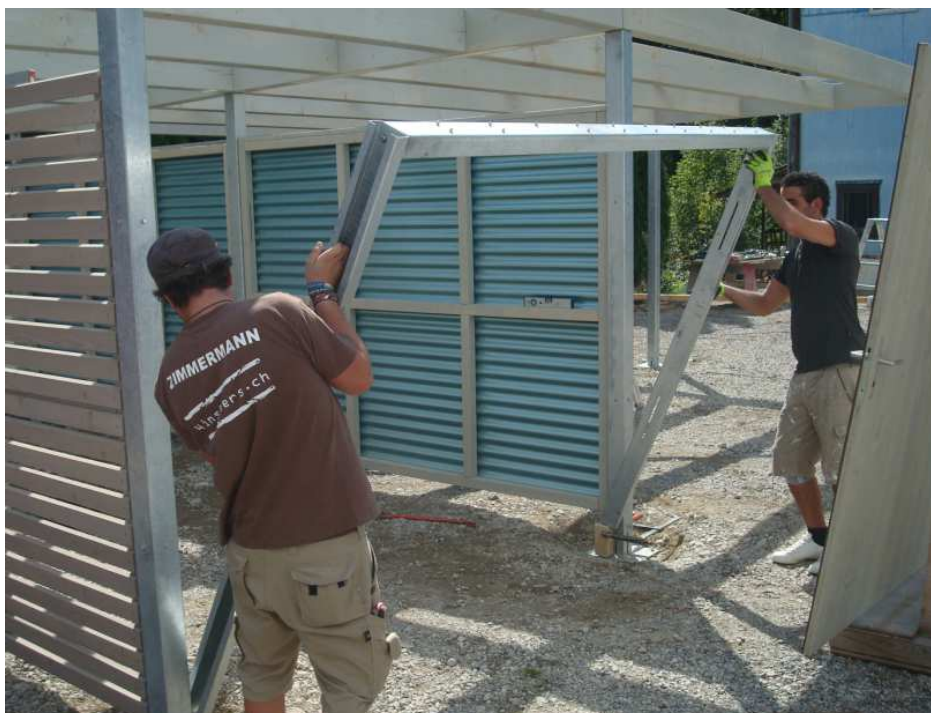
Schiebetürrahmen zwischen Pfosten einschieben
