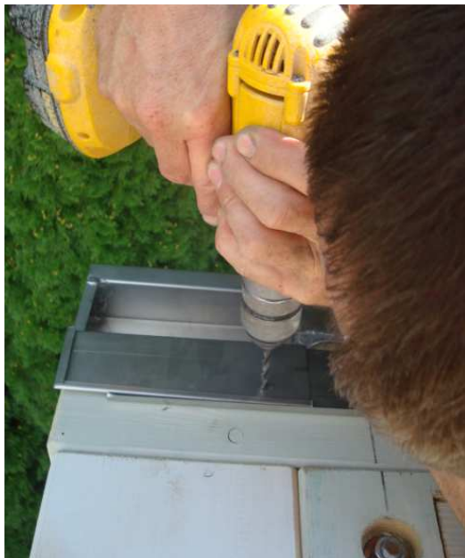
Bohren für Befestigung des Bodenstücks
