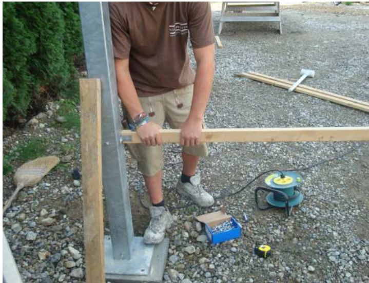
Montage der Wanddistanzplatte
