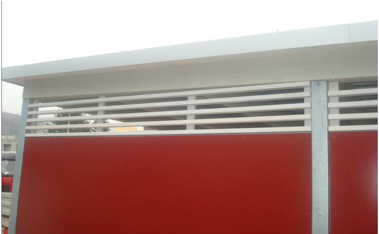
Lattenlichtband von aussen gesehen
