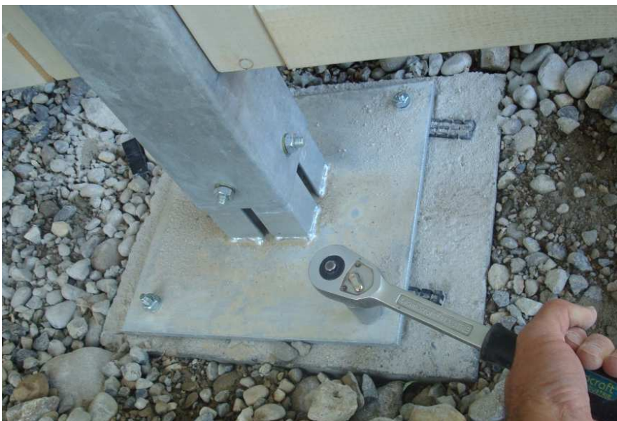
Pfostensockel auf Fundament befestigen nach der Wandmontage
