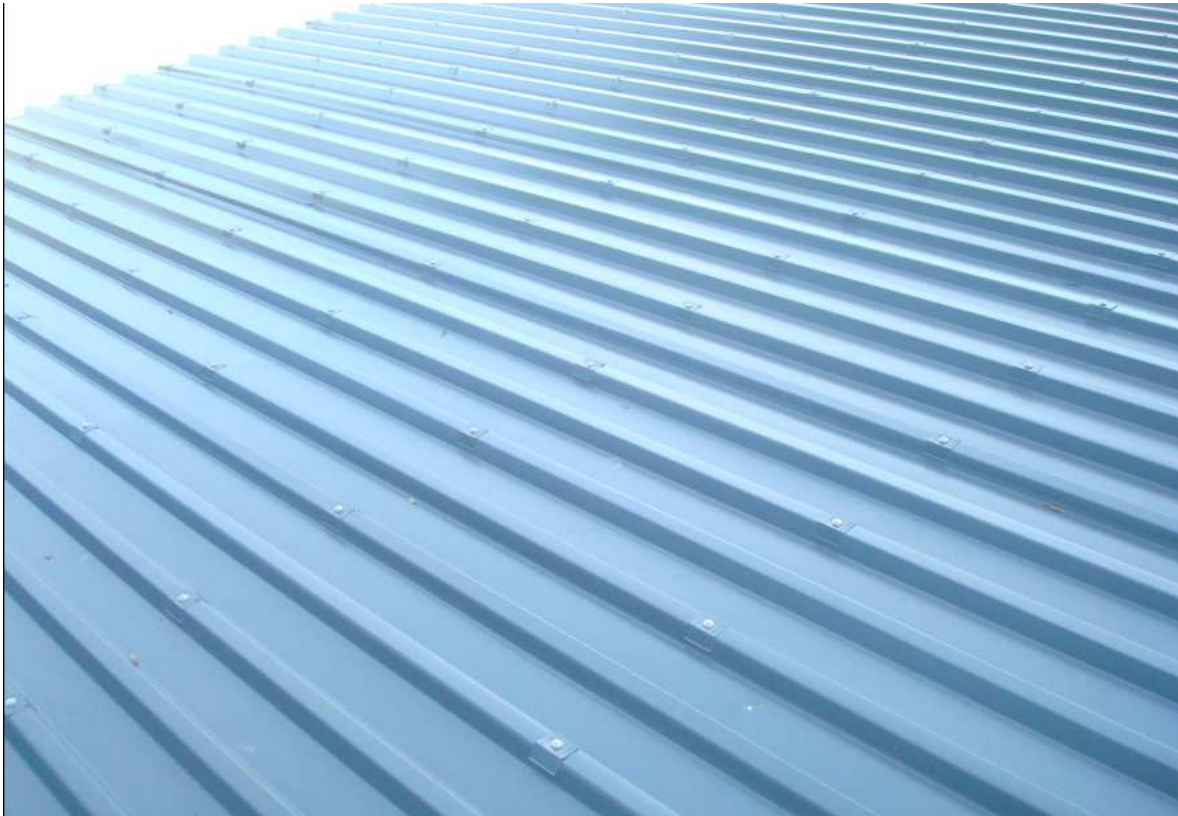
Fertig geschraubte Dachbleche
