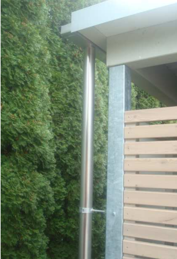
Fertig montierte Regenrinne mit Ablaufrohr
