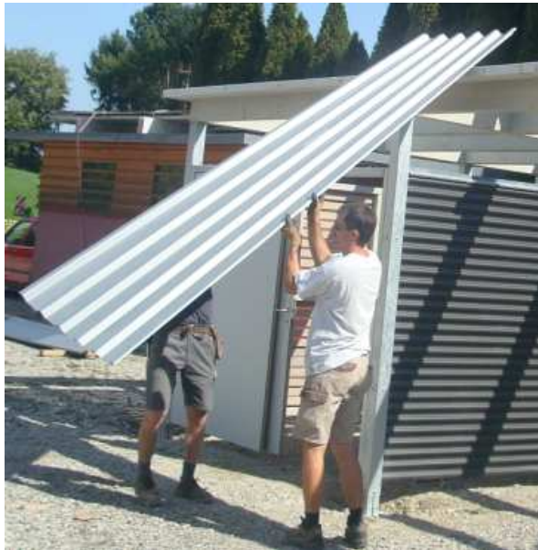
Erstes Blech auf Dach schieben
