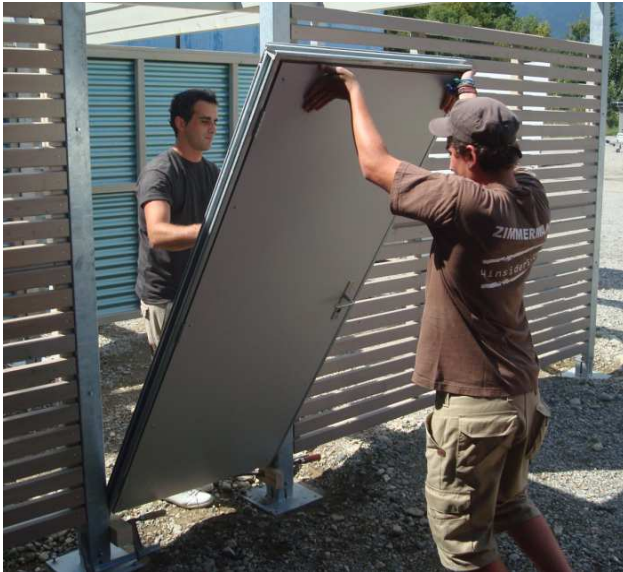
Tür mit Türrahmen zwischen Pfosten schieben
