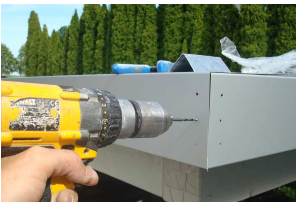
Bohren der Löcher 3.5 mm für Nieten
