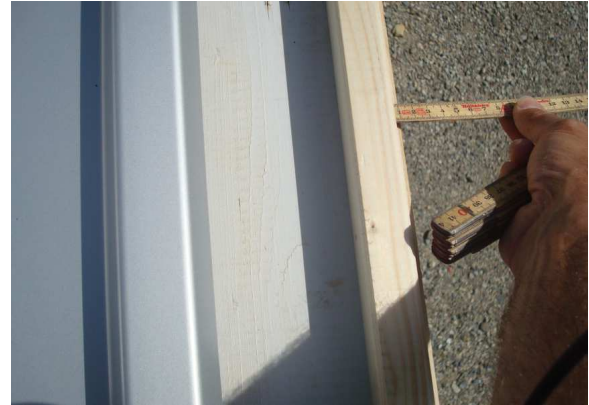
Unterlageleiste 1 cm von Ausserkante
