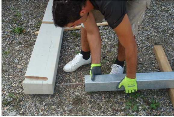
Pfosten mit Hauptträger verbinden
