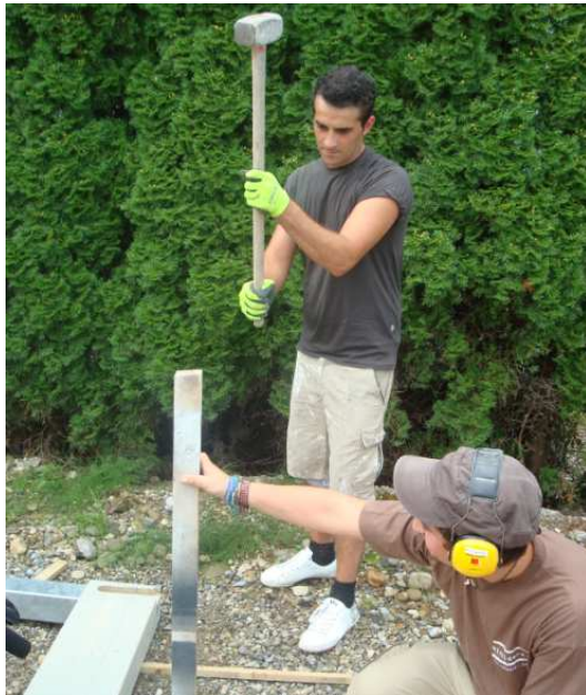
Sicherungspfosten zur Befestigung der Schwenklatte
