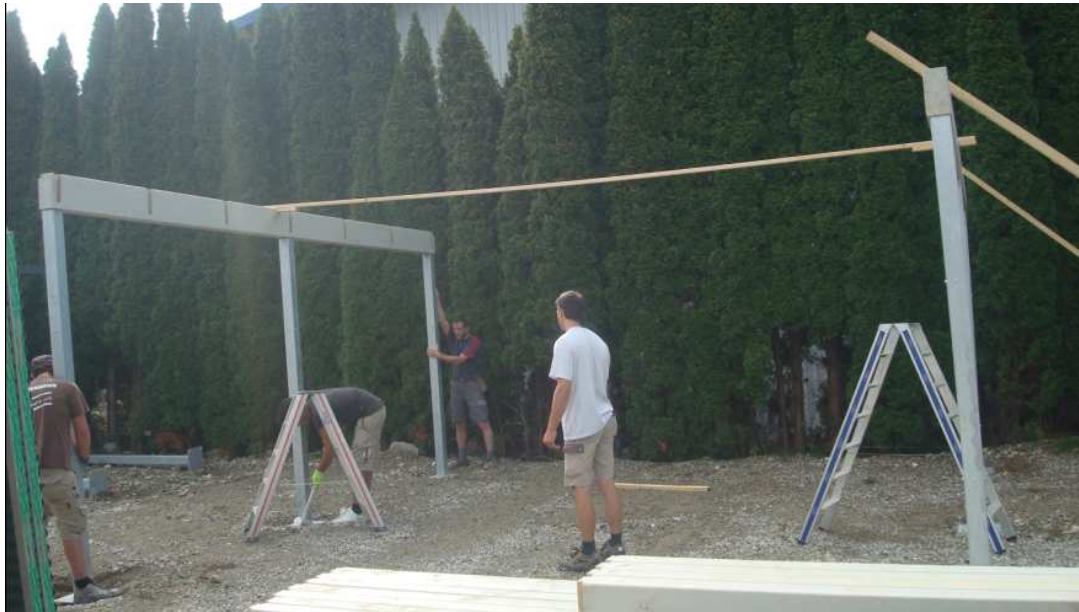
Erster und zweiter Hauptträger sind aufgestellt und provisorisch fixiert
