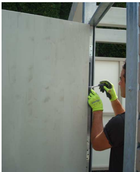
Befestigungsschrauben festziehen
