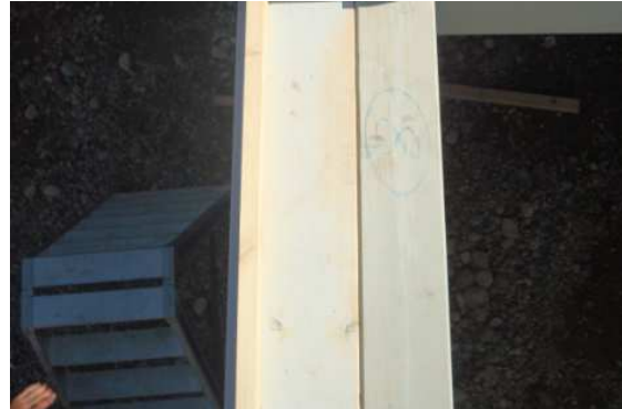
Unterlageleiste auf Randbalken
