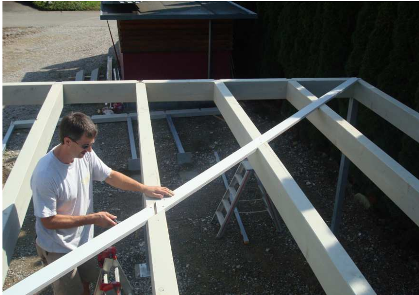
Windverband in Aussparungen montieren
