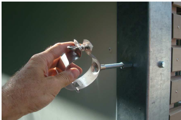
Rohrschellen montieren
