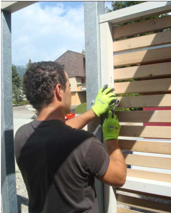
Befestigungsschrauben festziehen
