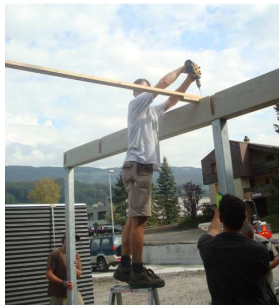
Distanzlatte unbedingt festschrauben
