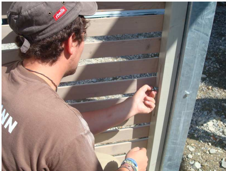
Befestigung der Seitenwände mit den Befestigungsschrauben
