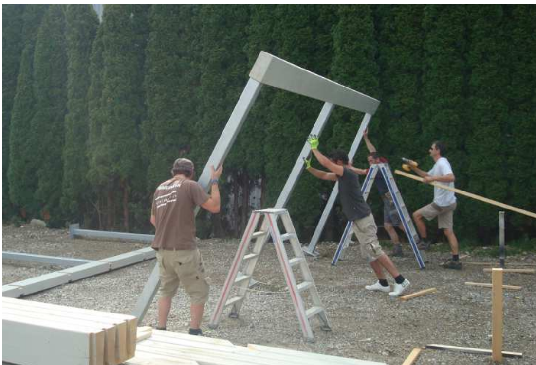
Aufstellen des ersten Hauptträgers
