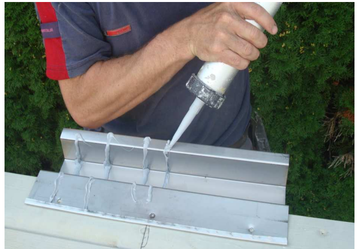
Baukleber auftragen
