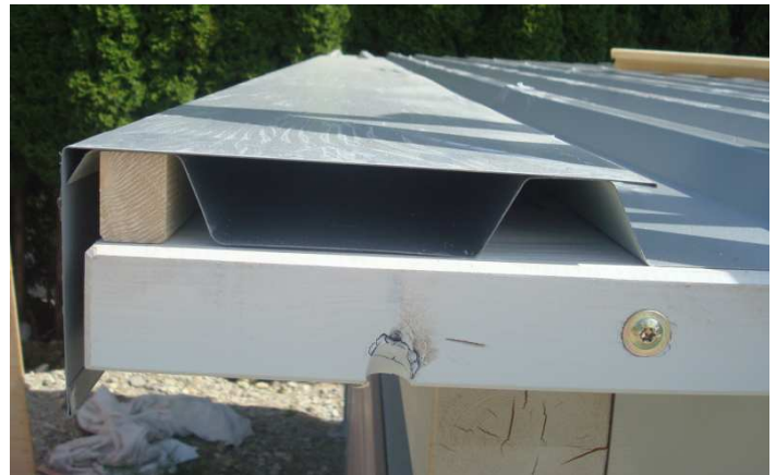
Erste Blechwelle über Unterlageleiste
