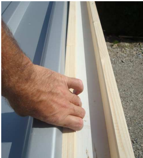
Zweite Unterlageleiste unter letzte Welle
