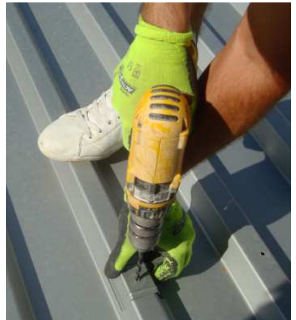
Bohrmaschine mit 8 mm Bohrer
