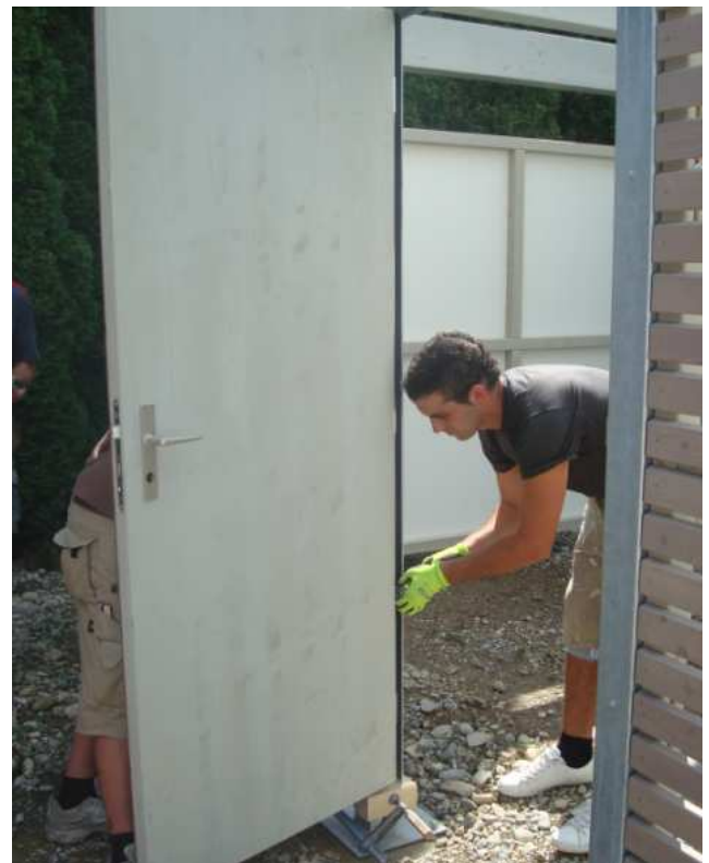
Befestigung Tür an Pfosten
