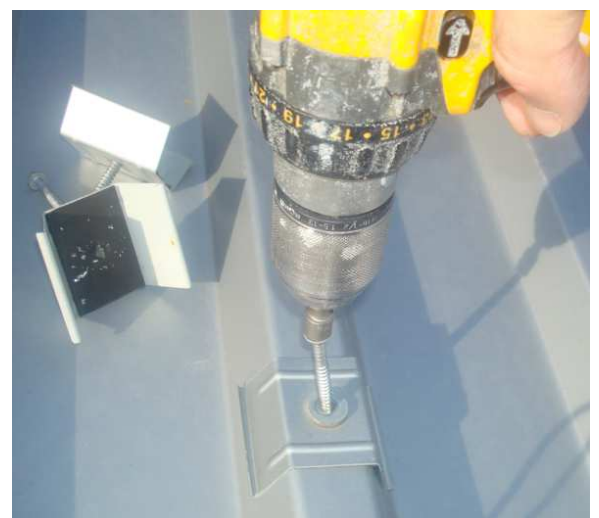
Schrauber mit 8 mm sechskant Aufnahme
