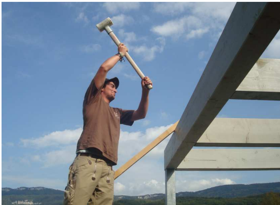
Anklopfen der Balken von der Bockleiter aus
