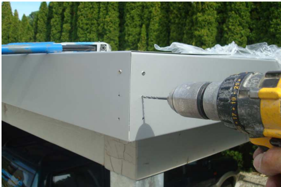
Durch Blenden Eckblech bohren
