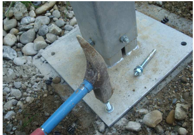
Setzen des Betonankers
