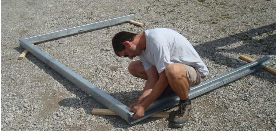
Türrahmen am Boden auslegen und zusammenschrauben
