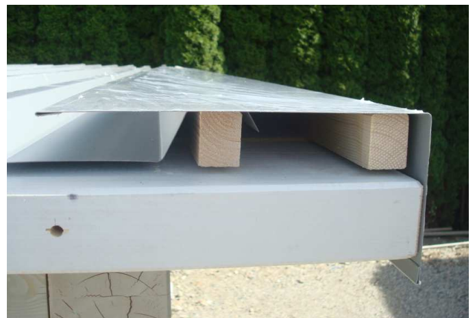
Unterlageleisten als Auflage der Blende
